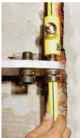
Thermofusión en la canaleta.
