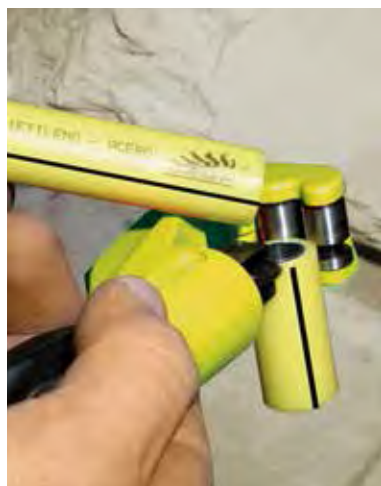
Corte con corta-tubo en obra.
